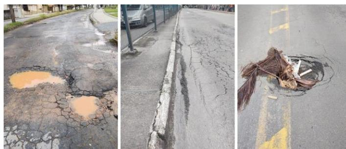
Figura 4. Manifestações patológicas na região Central: panelas, trincas interligadas, afundamentos, escorregamento.
