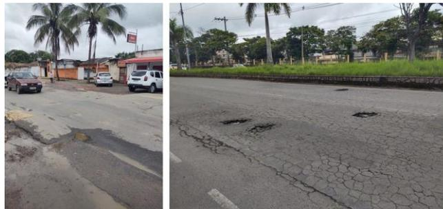
Figura 8. Manifestações patológicas na região Norte: afundamento, trincas e buracos. Fonte:
