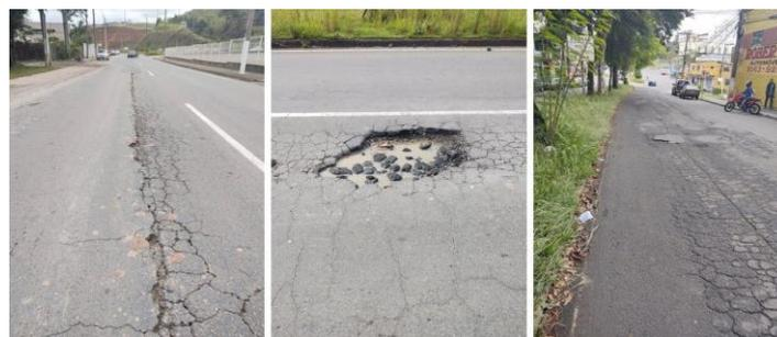
Figura 9. Manifestações patológicas na região Oeste: trinca longitudinal, panela, remendos, trincas interligadas, corrugação e desgaste.
