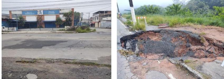
Figura 7. Manifestações patológicas na região Noroeste: remendo, afundamento, desgaste, trincas e panela.
