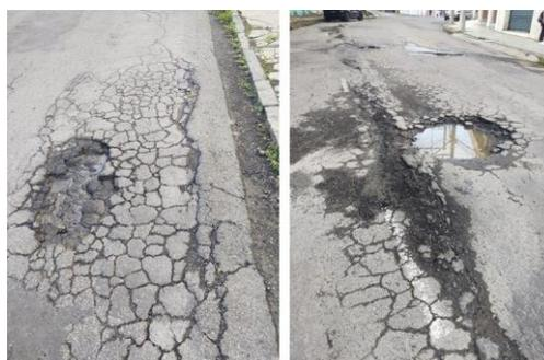
Figura 5. Manifestações patológicas na região Leste: buraco, afundamento, ondulação, trincas.
