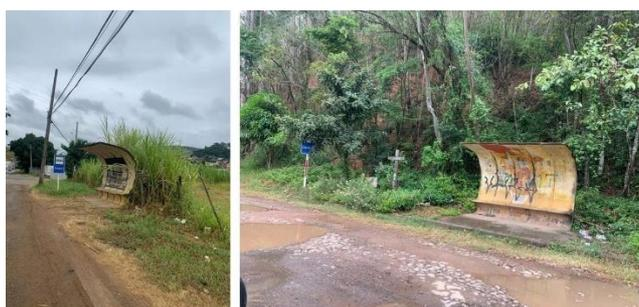
Figura 18. Pontos de ônibus na região Sudeste: ausência de capinagem, proteção lateral e falta de acessibilidade na calçada.
