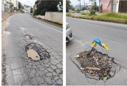
Figura 6. Manifestações patológicas na região Nordeste: panelas, trincas interligadas. Fonte:
