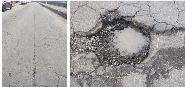
Figura 11. Manifestações patológicas na região Sul: trinca longitudinal, panela.
