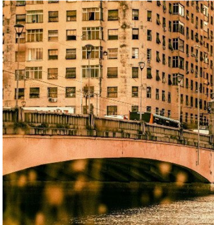
Figura 9 – Foto da Ponte Duarte Coelho, Recife-PE
