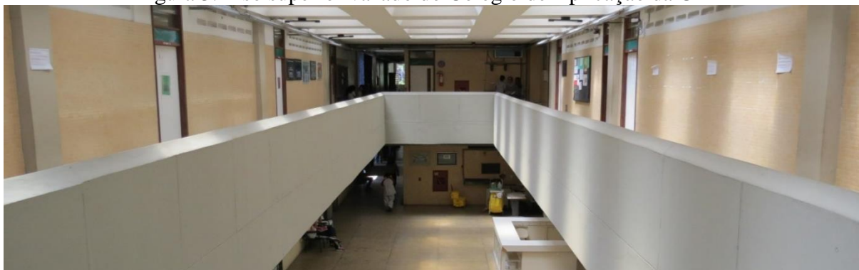
Figura 3. Piso superior vazado do Colégio de Aplicação da UFPE
