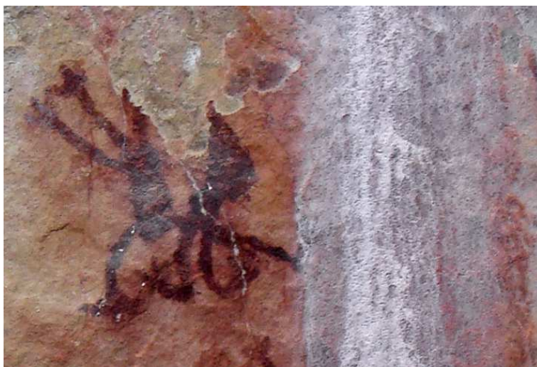
Figura 8. Suporte rochoso com manchamentos, deslocamentos e eflorescência salina. Sítio Toca do Gato, Ibimirim - PE. (jul/2009).
