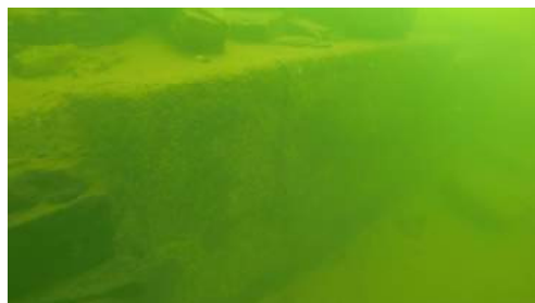
Figura 6. Registro do alicerce de concreto do Sítio Casa Grande. Data: 18/08/2016.
