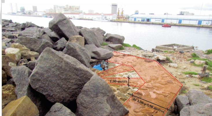
Figura 11. Estrutura remanescente do Forte de São Francisco da Barra, porção norte, em formato de um polígono regular de nove lados e trecho das fiadas com alvenaria irregular com rocha.
