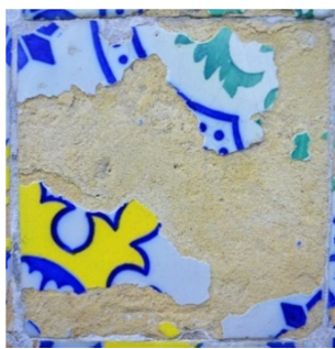
Figura 23. Esfoliação – Desagregação com desprendimento de lâminas (descamação) do vidrado e chacota.
