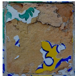
Figura 15. Concreção – Massa endurecida, formada pela precipitação ou exsudações magnesianas ou calcárias, sucessivas
