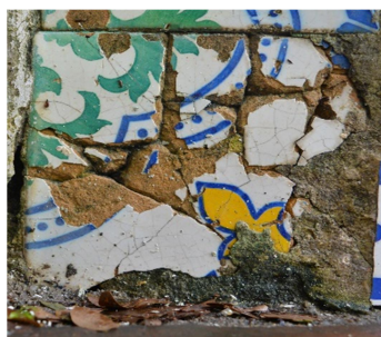
Figura 16. Desagregação – Reação física de esfacelamento e dissolução do corpo cerâmico e vidrado em decorrência de ações físico-químicas deletérias.
