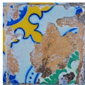
Figura 18. Eflorescência – Depósitos, geralmente brancos e porosos, sobre o corpo cerâmico do azulejo.
