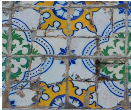
Figura 31. Reintegração – Manufatura de fragmentos de azulejo e vidro para preencher as lacunas volumétricas ou cromáticas.
