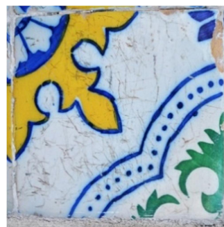
Figura 29. Riscos – Traços, sucros, ou linhas feitos em diferentes proporções na superfície do corpo cerâmico.
