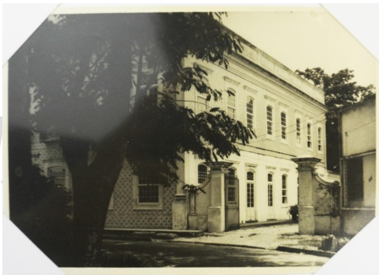
Figura 6. Fotografia de 1983, na qual se registra a ausência de azulejos na parte inferior (térreo), da fachada leste do Mab. Iphan 5ª diretoria Regional de Pernambuco, Acervo Iconográfico.
