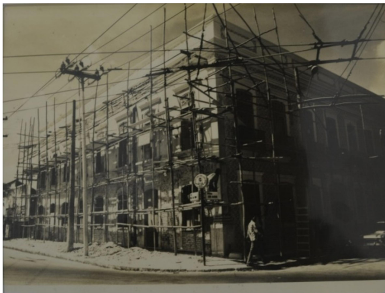
Figura 5. Registro de 1972, da intervenção no antigo Sobrado da Madalena para sua adequação ao Mab e na qual se removeram todos os azulejos das fachadas oeste e sul, para posterior recolocação ou substituição. Iphan 5ª diretoria Regional de Pernambuco, Acervo Iconográfico.
