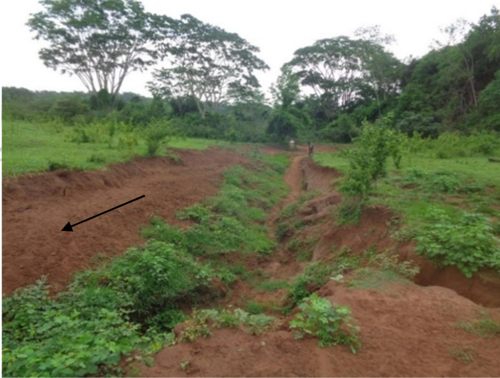
Figura 4: Vista parcial da ravina 1, junto à margem direita do córrego do Muquém. A seta indica o sentido do fluxo pluvial.
