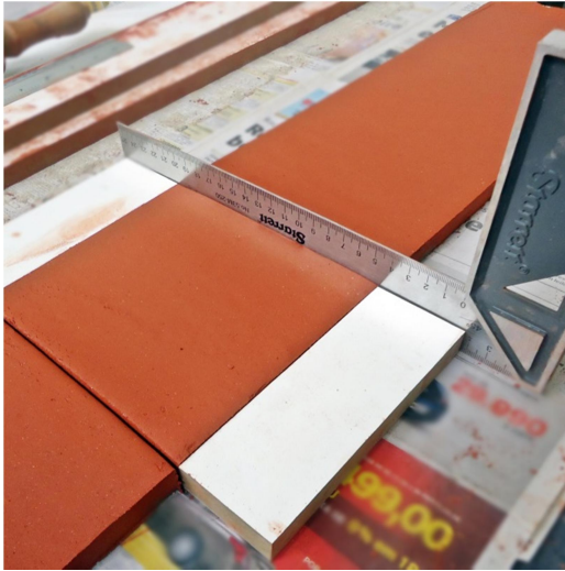
Figura 21 – As peças são medidas e cortadas com o próprio esquadro de aço.
