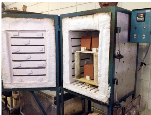
Figura 34 – Peças inseridas no forno elétrico Arts Fire - Kilns & Supplies, para realização da queima no Ateliê de Desenho, Pintura e Modelagem em Argila, pertencente ao Departamento de Teoria da Arte da UFPE.
