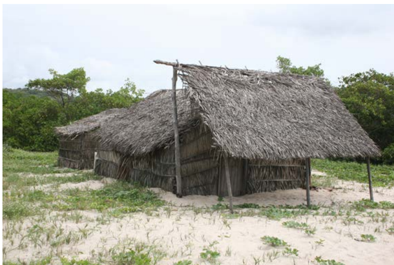
Figura 4 Casa em palha, Abiaí -PB
