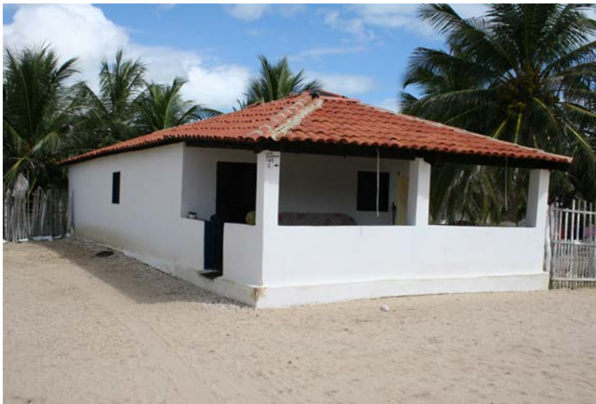
Figura 12 Casa em alvenaria, Barrinha -CE
