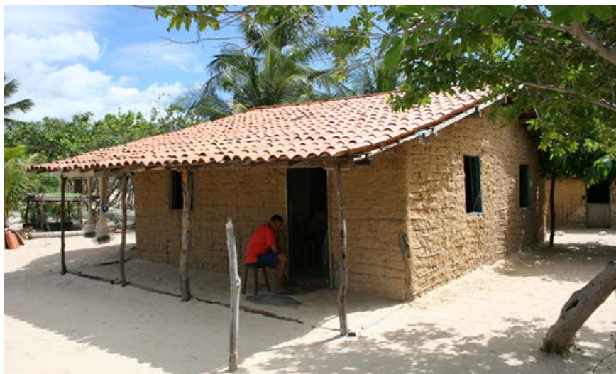
Figura 6 Casa em taipa, Quitéria – CE, Planta baixa, perspectiva estrutura, foto
