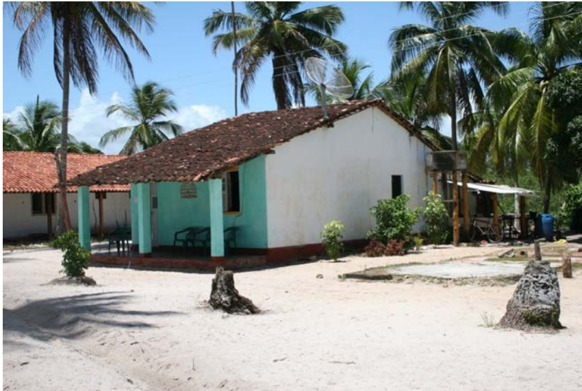
Figura 13 Casa em alvenaria, Vila de Contrato -BA
