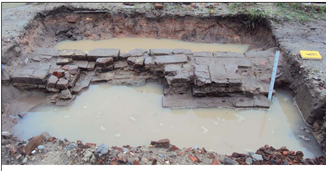
Figura 10: Valas inundadas pela água das chuvas provocando desmoronamento dos perfis estratigráficos e dificultando a evidencição e registro da estrutura arqueológica.
