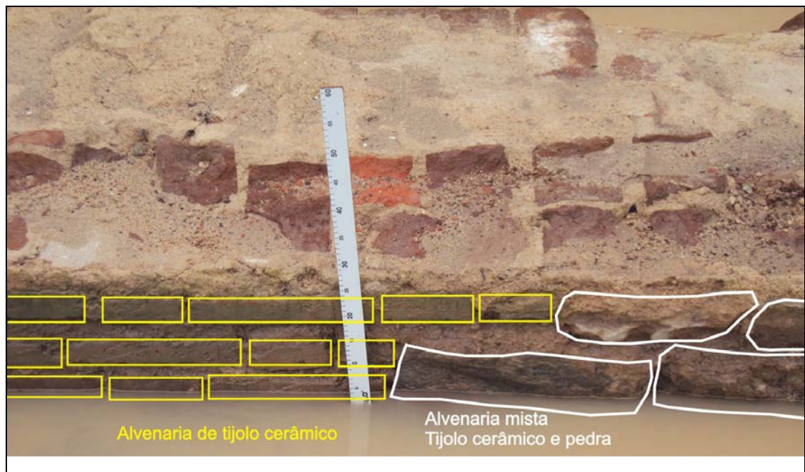
Figura 17: Alvenaria de tijolo cerâmico maciço e alvenaria mista - tijolo cerâmico maciço e pedra. Estrutura BP101D.
