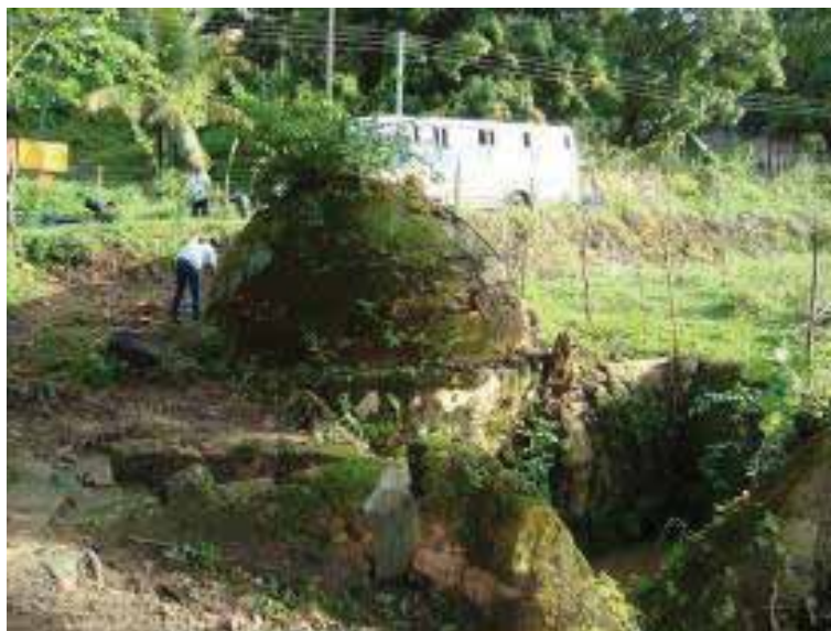
Figura 4 – Estruturas de comportas e escadaria ligadas à bica. Nota-se vegetação saindo do topo da cobertura.
