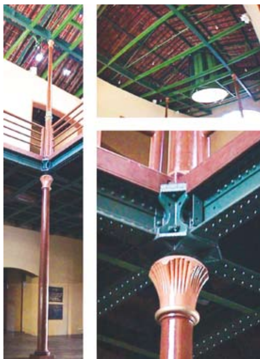
Figuras 4a, 4b e 4c: Colunas que vão do térreo ao primeiro pavimento e estrutura da coberta e da lanterna da Estação Central.
