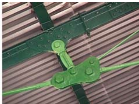
Figuras 6a e 6b: Detalhes das conexões entre bielas e tirantes na treliça da plataforma na Estação Central.
