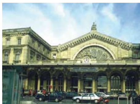
Figura 7: Fachada frontal da Gare de l'Est.
