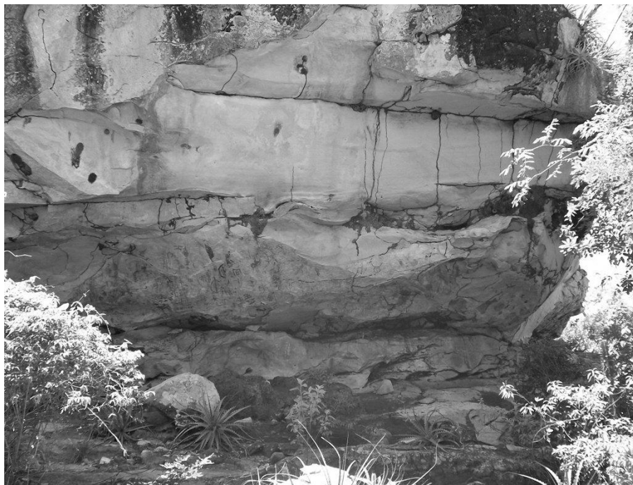
Figura 3: Vista parcial do abrigo Pedra do Dicionário, Piripiri, Piauí.
