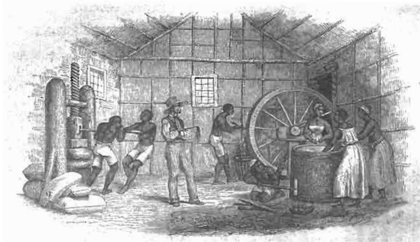
**Figura 4: Ilustração de um engenho de farinha da primeira metade do século XIX. Vê-se o uso da prensa, roda d'água, fornalha e um tacho ou torrador. Nota-se ainda o envolvimento de homens e mulheres escravas no seu processamento (KIDDER, 1845: 242).**
