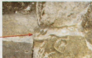
ENCAIXE DAS PEDRAS NO ÂNGULO ENTRE O FLANCO E A CORTINA
