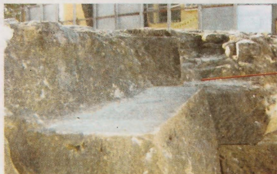
DETALHE DO ENCAIXE DAS PEDRAS ^ JUNTADOUROS ^
