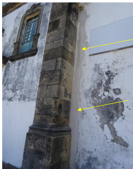
Figura 16. Intervenção com uso de cimento. Fonte: acervo próprio (2022).
