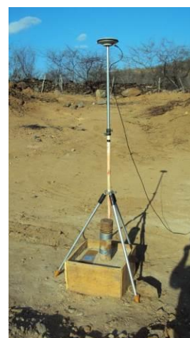
Figura 52 - Antena receptora do GPS sobre o marco do furo de Riacho Fechado.
