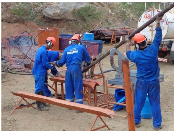
Figura 21 – Operação/manobra de recuperação e limpeza de testemunho.
