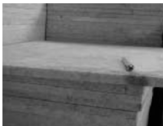
Figura 7 - Manchas decorrentes de armazenamento inadequado.
