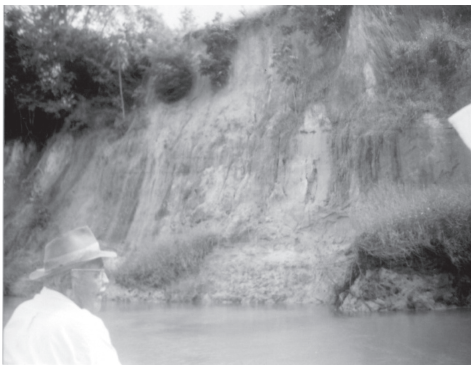
Foto 4 – Estação à margem do Rio Mega Ó (PE)
