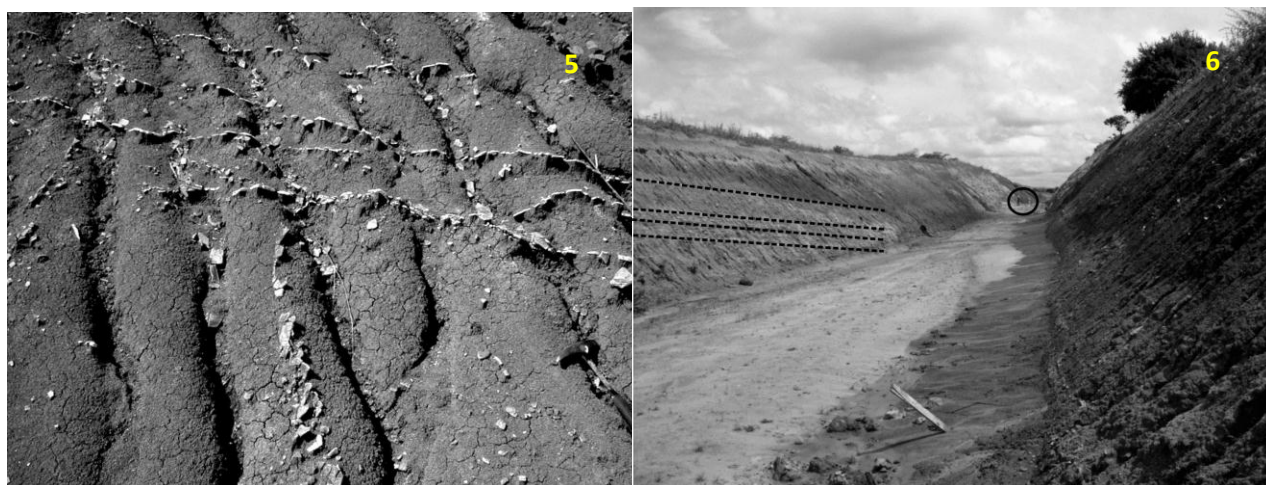
Figura 5 – Lâminas de calcita nos folhelhos da Formação Brejo Santo em corte da Ferrovia Transnordestina. Figura 6 – Visão geral das rochas da Formação Brejo Santo em corte da Ferrovia Transnordestina próximo à cidade de Brejo Santo (ponto JT-15). Notar mergulho das camadas para sul ( \sim 10^\circ ). Círculo indica escala.
