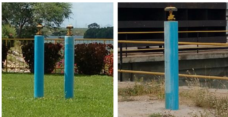
Figura 3 – Vértices geodésicos P1 e P2 (esquerda) e P5 (direita) com receptores GNSS instalados
