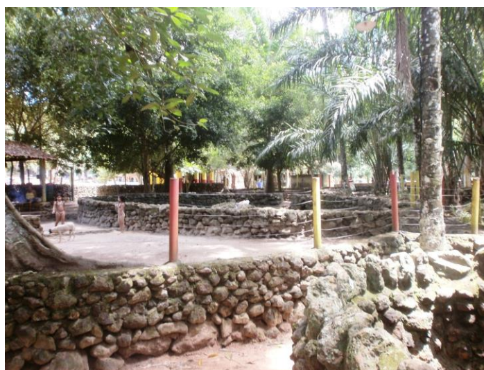
Figura 11. Rochas utilizadas na construção do balneário da Piscina da Nascente.
