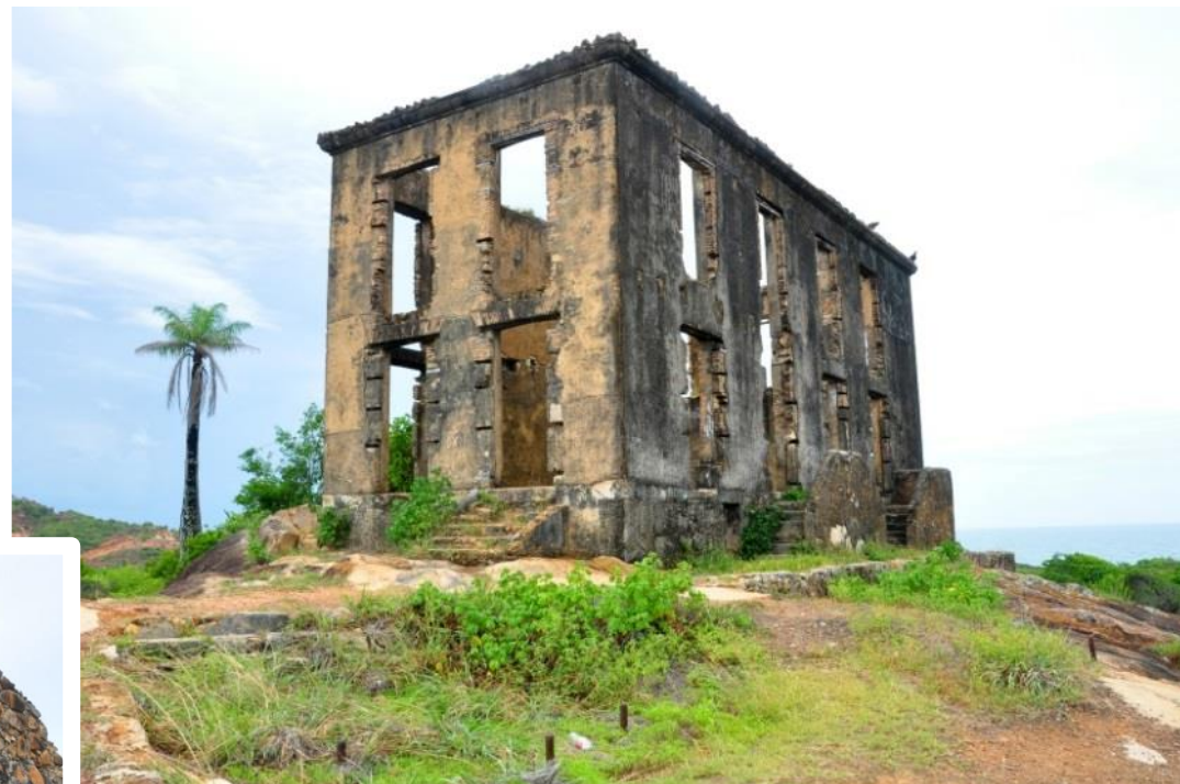
Figura 13. Ruínas da Casa do Faroleiro.
