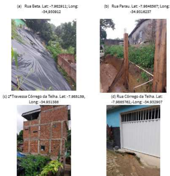
Figura 2. Área de encosta com (a) lona em mal estado e (b) Moradia inacabada (c) Construções irregulares e (d) drenagem em frente a residência Fonte: Os autores (2023).
