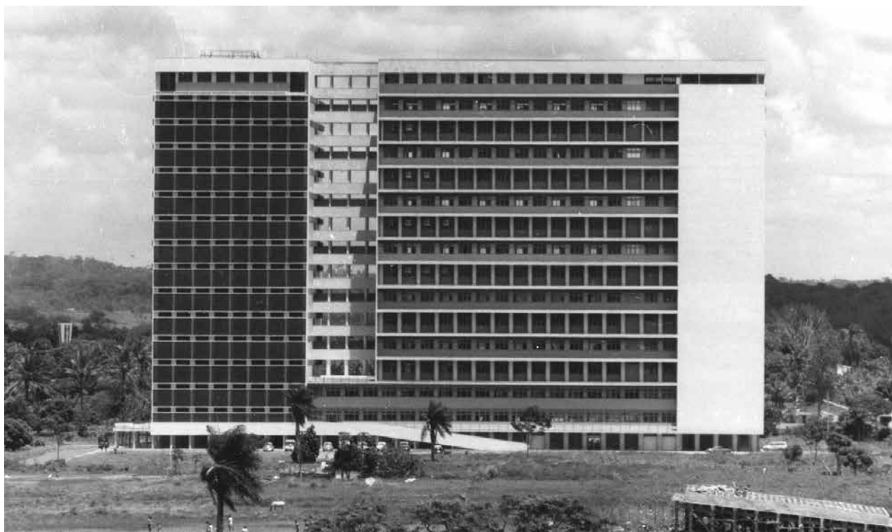
Construção do prédio do CFCH/UFPE
