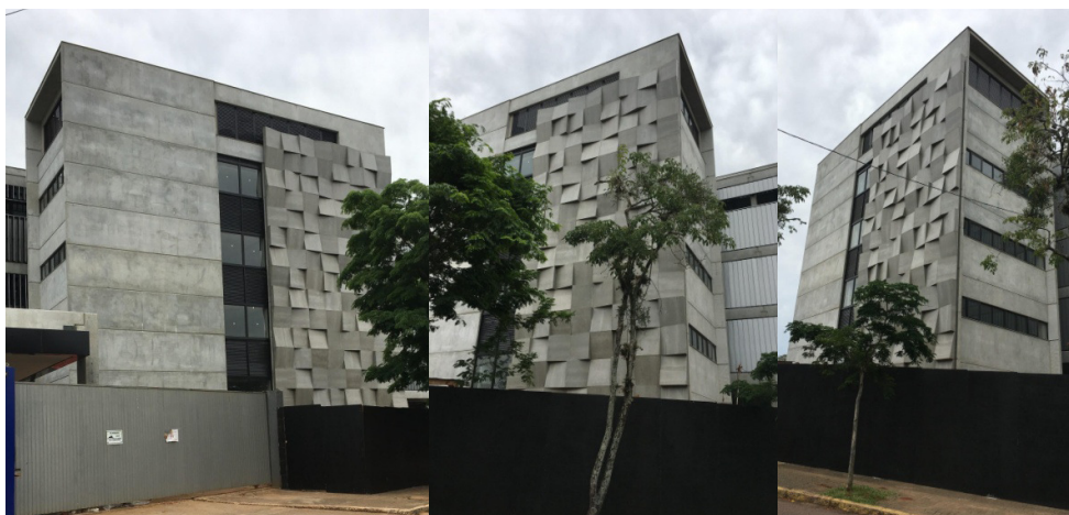
Figura 4: Paineis em pré-moldado na fachada da edificação.
