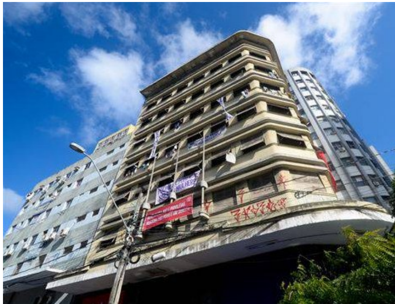
Figura 3. Vista do Edifício Sulamérica, no centro do Recife
