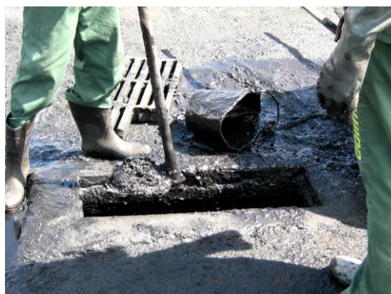
Figura 02 - Limpeza dos drenos: aspecto do resíduo a ser drenado para o mar
