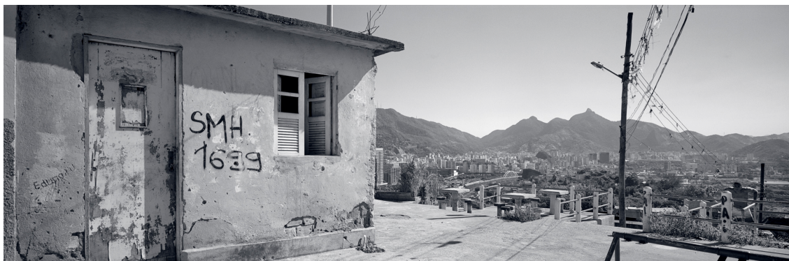
Figura 2: Fotografia de Cesar Barreto. Vista do Morro da Providência. As letras e números pintados na parede da casa, SMH (Secretaria Municipal de Habitação) 1699, indica que a residência será demolida (2012).
