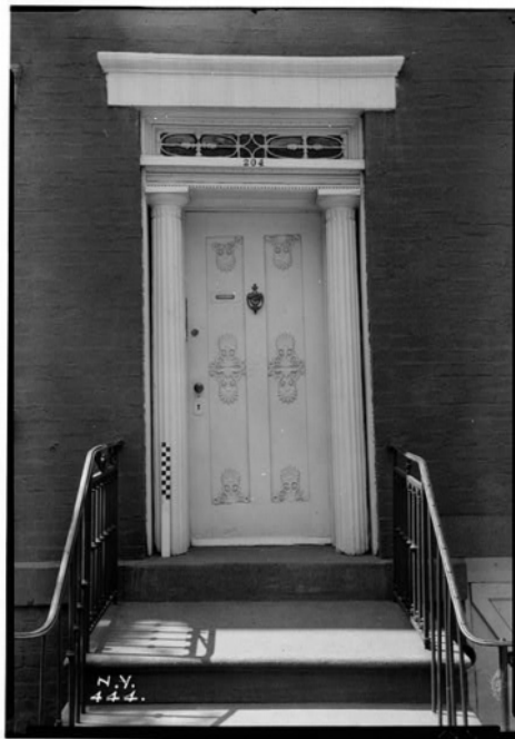
Ilustração 1: fotografia de Arnold Moses que integrou os arquivos do Historic American Buildings Survey.
