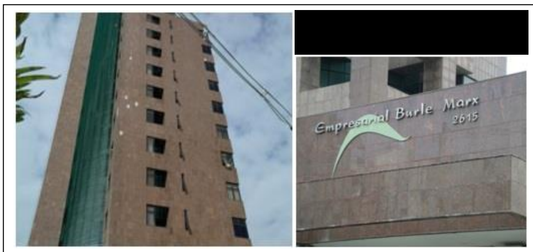
Figura 2 - Edifício Burle Marx, Av. Agamenon Magalhães, 2615, Recife, PE.
