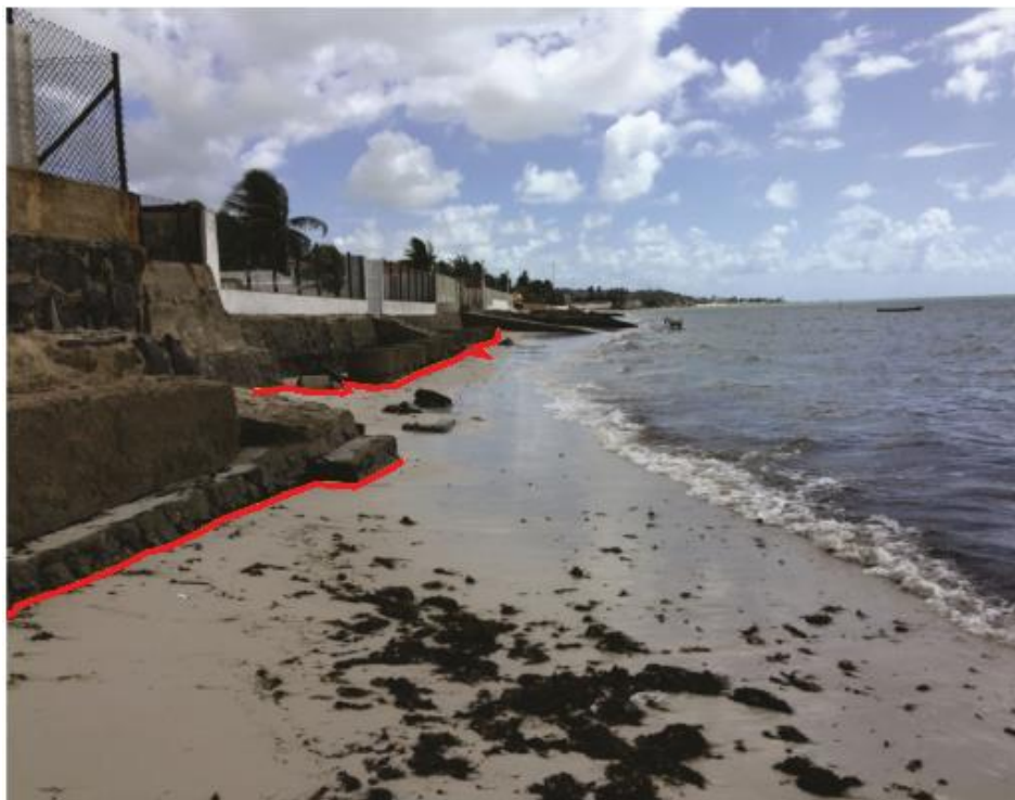
Figura 5 – Estruturas de muros construídas para conter a ação das ondas. A linha vermelha representa o local nas construções onde foi delimitada a linha de preamar máxima.
