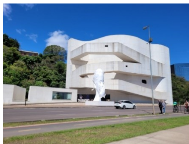
Figura 15 - Fundação Iberê Camargo, moldura / base unificadora
