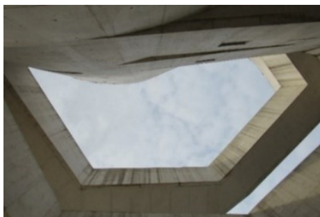
Figura 17 - Fundação Iberê Camargo. Molduras sobre a esplanada. Plasticidades do concreto
