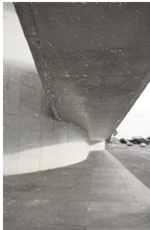
Figura 11 - Fundação Iberê Camargo, detalhe da torre que extravaza e avança sobre o passeio, submetida às pressões internas do crescimento orgânico
