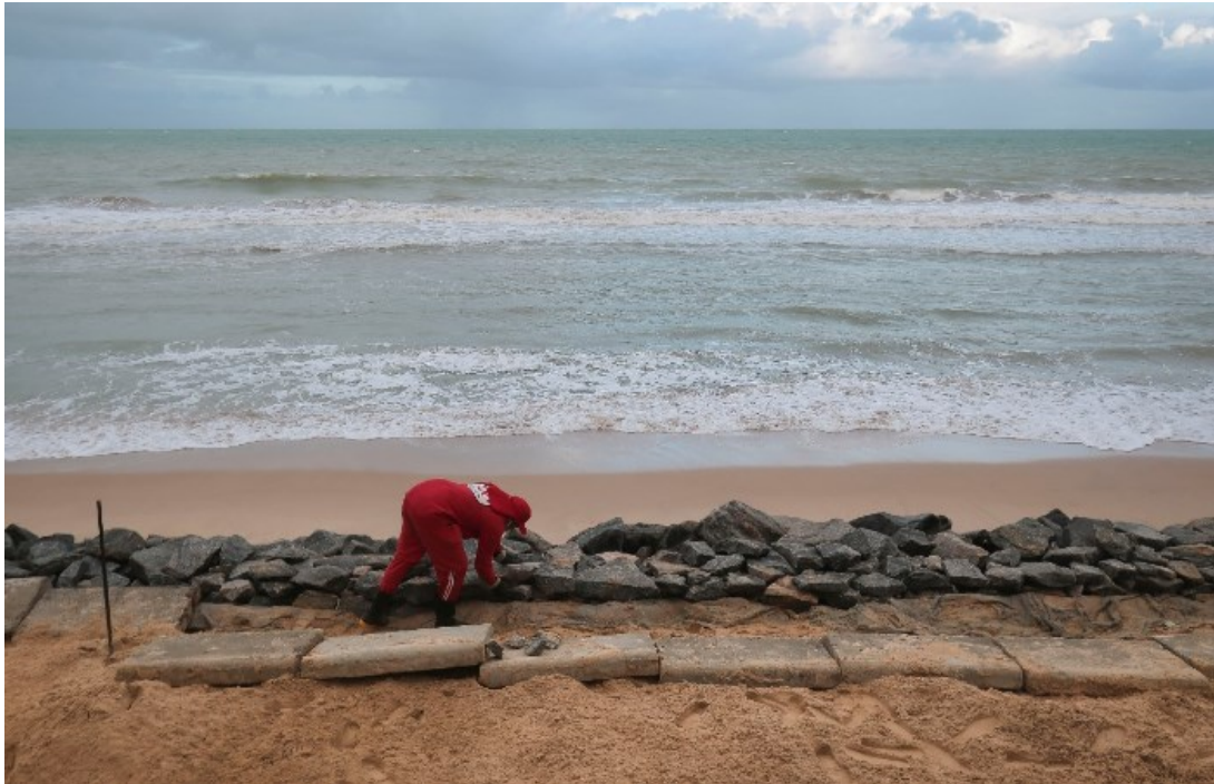
Figura 2 - Praia de Boa Viagem recebeu pedras para contenção do mar. A manutenção do enrocamento é feita pela Emlurb. (Foto: Tarciso Augusto/Esp. DP. 2020)
