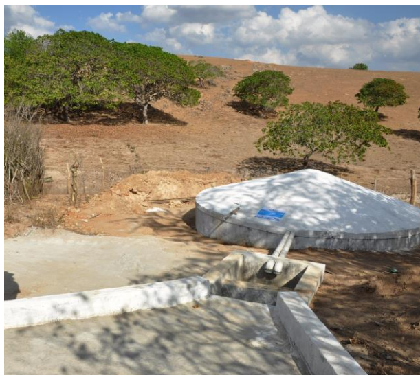
Figura 6 – Cisterna-enxurrada construída pelo Programa Uma Terra e Duas Águas (P1+2) da Articulação no Semiárido (ASA). Fonte: Paulo Lopes - Arquivo Fotográfico da ASA (2013).
