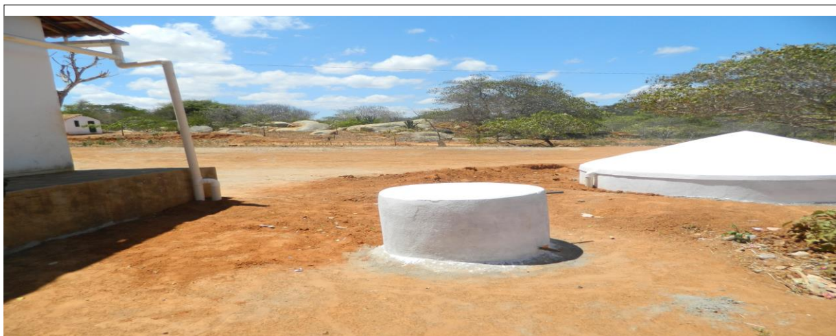
Figura 3 – Cisterna com sistema de boia construída pelo Centro de Educação Popular Formação Popular, em Teixeira, PB. Fonte: Adailson Vital – Arquivo Fotográfico do CEPFS (2012).
