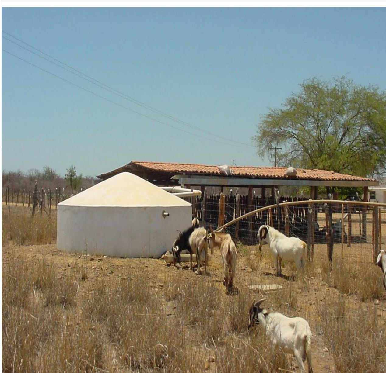
Figura 7 – Cisterna-aprisco no Campo Experimental da Embrapa Semiárido, em Petrolina-PE.
