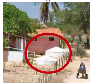
Figura 1 - Cisternas com capacidade para 16 mil litros do Programa Um Milhão de Cisternas (P1MC), da Articulação no Semiárido (ASA). Fonte: Paulo Lopes – Arquivo Fotográfico da ASA (2013).
