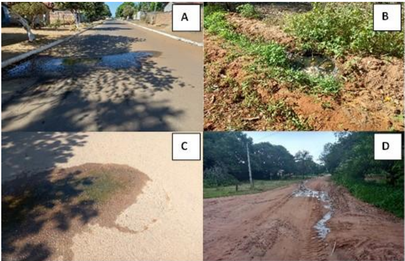
Figura 7: Pontos de esgoto a céu aberto nas ruas de Conceição do Araguaia, Vazamento aflorando no asfalto (A), Bueiro sem tampa as margens da avenida Contorno (B), marca do bueiro no asfalto (C) e vazamento ao longo da rua Contorno no Bairro do Setor Universitário (D).
