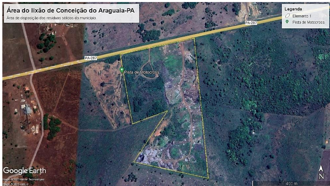
Figura 8. Imagem aérea de despejo ao ar livre de resíduos sólidos em Conceição do Araguaia-PA, na PA-287 a 5 km de distância do centro da cidade.
