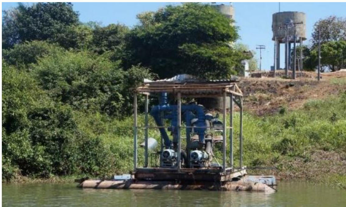
Figura 3. Flutuante com bomba de captação de água no Rio Araguaia no município de Conceição do Araguaia – Pará.
