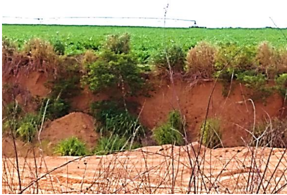
Figura 23: Erosão em topo de tabuleiro causada pela abertura de uma estrada no DISTAR (primeiro plano). Visualiza-se em segundo plano plantação de capim para forragem, irrigado com pivô central (linha do horizonte).
