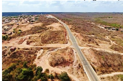
Figura 14: Severas erosões em borda de tabuleiro devido ao uso e ocupação intensivos (à esquerda) e
