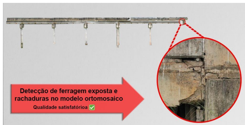
Figura 12. Detalhe das manifestações patológicas detectada através do modelo ortomosaico na vista oeste.
