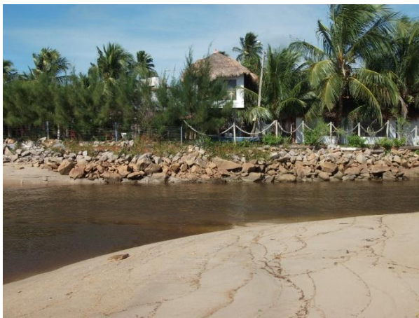
Figura 8: Estuário do Rio Persinunga com estrutura de contenção da margem.
