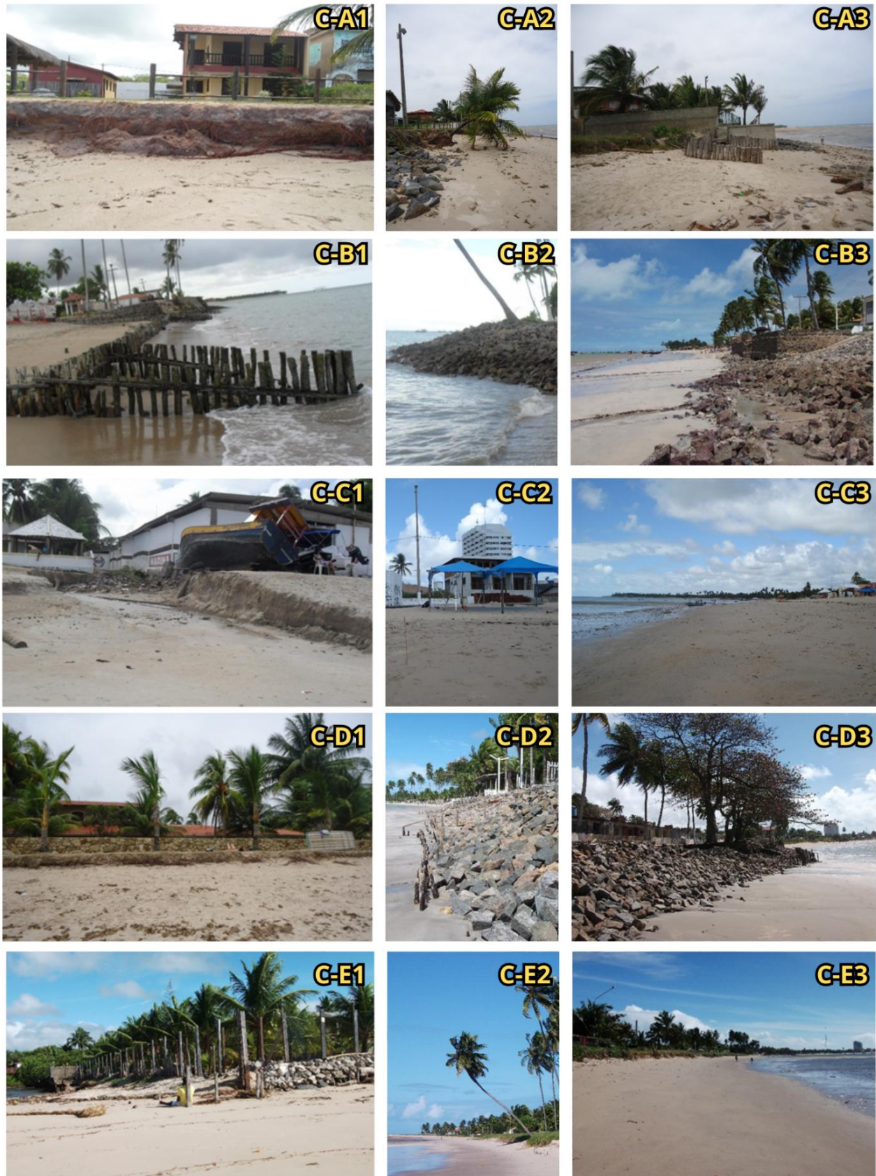
Figura 4: Análise da dinâmica costeira da Praia de São José da Coroa Grande-PE. Distribuição por Cédulas (C) de vulnerabilidade. CA1 a CA3- Erosão pós-praia com contenção contra o avanço do mar; CB1 a CB3- Contenção praiar moderada; CC1 a CC3- Intensificação da contenção do avanço do mar entre baixo a médio; CD1 a CD3- Contenção entre médio a alta; CE1 a CE3- Contenção aos processos erosivos entre baixo a médio.
