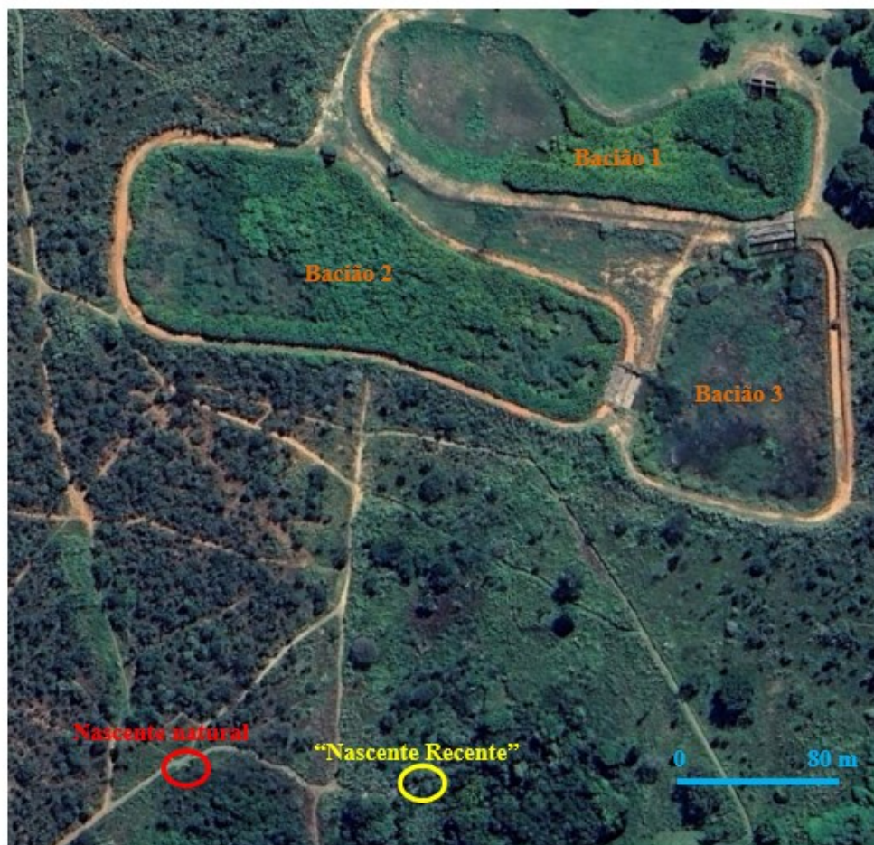
Figura 8: Detalhe do sistema de baciões instalados à montante das nascentes do Córrego Veredinha para contenção das águas pluviais geradas no bairro São José (Imagem do sistema Google Earth de 24 de abril de 2023). O ponto destacado em vermelho é a localização da nascente vinculada a fluxo intermediário a regional. O ponto em amarelo é referente à “Nascente Recente” associada ao fluxo local, que surgiu após a instalação do sistema de baciões.
