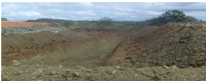
Imagem 3 – Visão de parte do Canal da transposição no território de Santana. Imagem 4 – Detalhe da escavação do canal.
