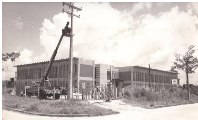
FOTO 5: Construção do CE/UFPE, 1974
