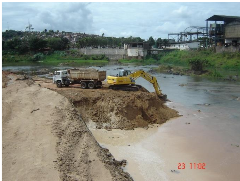
Figura 12 - Obras no Rio Una trecho urbano de Palmares. Fonte: Alves (2017).
