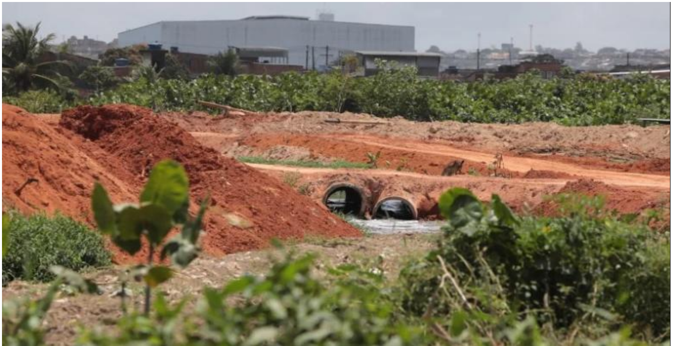
Figura 12. Obras no Canal Mariana. Fonte: Guga Matos/JC Imagem, 2024.
