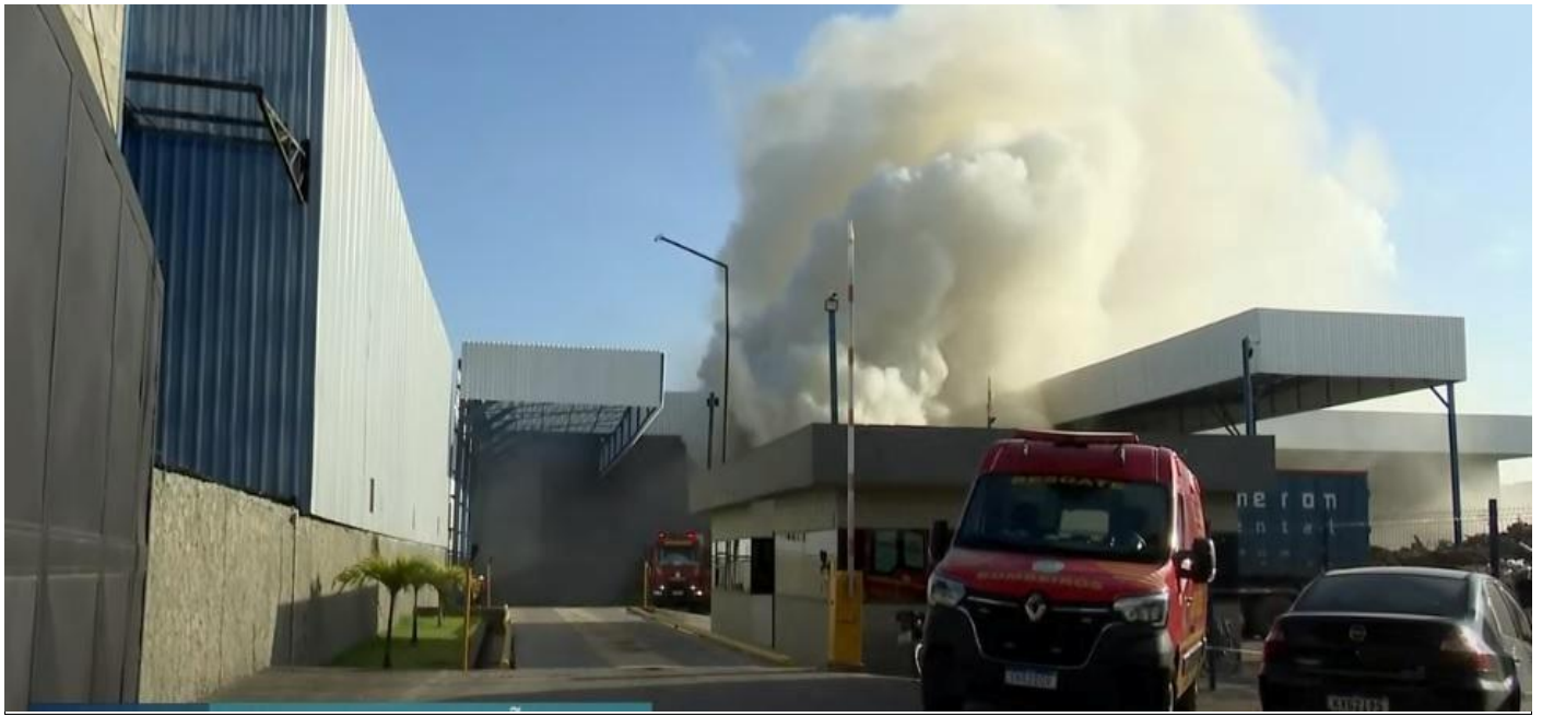
Figura 13. Incêndio em Fábrica localizada em Muribeca. Fonte: Reprodução/TV Guararapes, 2024
