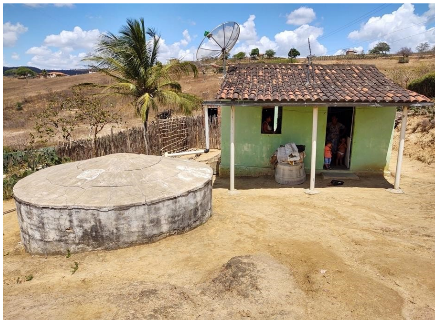
Figura 3 - Uma das primeiras cisternas construídas no município de Cumaru, na casa de Seu Severino.
