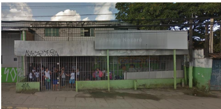
Figura 5. Escola Jesus de Nazaré, Jaboatão dos Guararapes, PE. Fonte: GoogleMaps, 2019.
