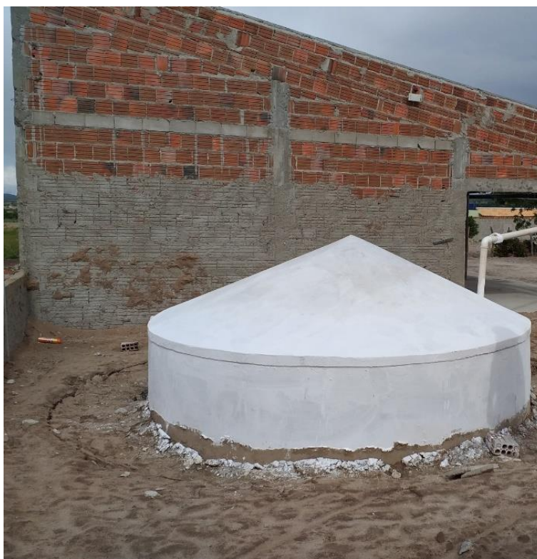
Figura 1: Cisterna de placa de cimento construída no âmbito do P1MC
