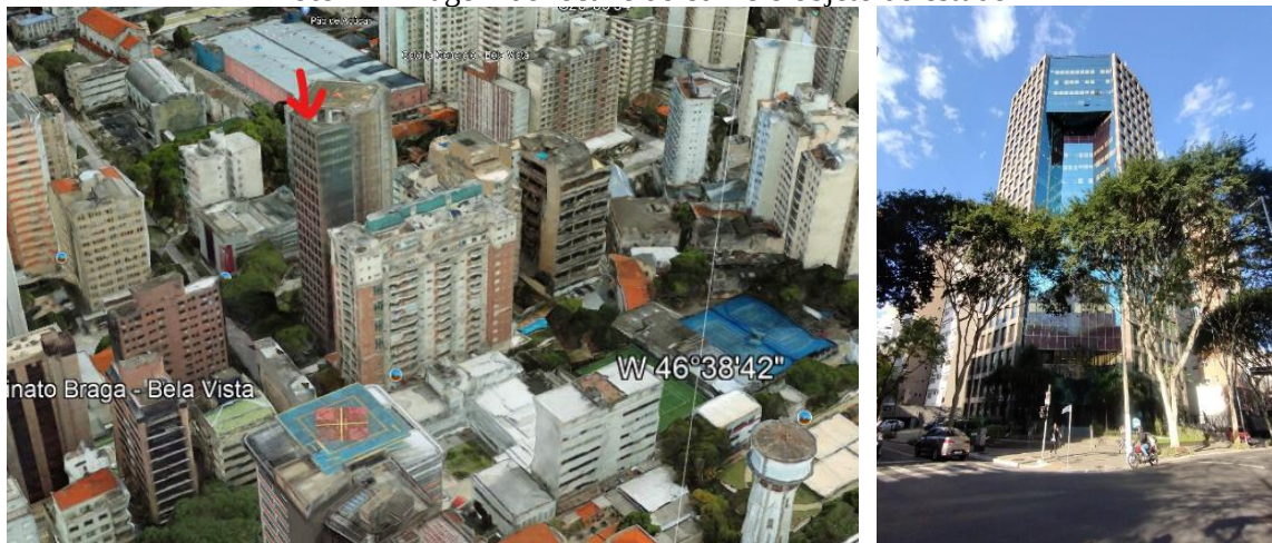
Foto 1 – Imagem do local e do edifício objeto do estudo
