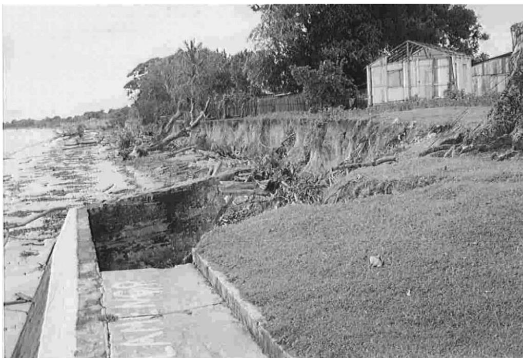
**Figura 13.** Exemplo da destruição sofrida pelo cais em um período de apenas dois anos após sua construção.
